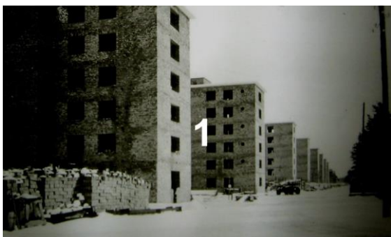
1. Uppförande av trapphuset, vinter 1938/39 Arkiv Dokumentationscenter Prora
